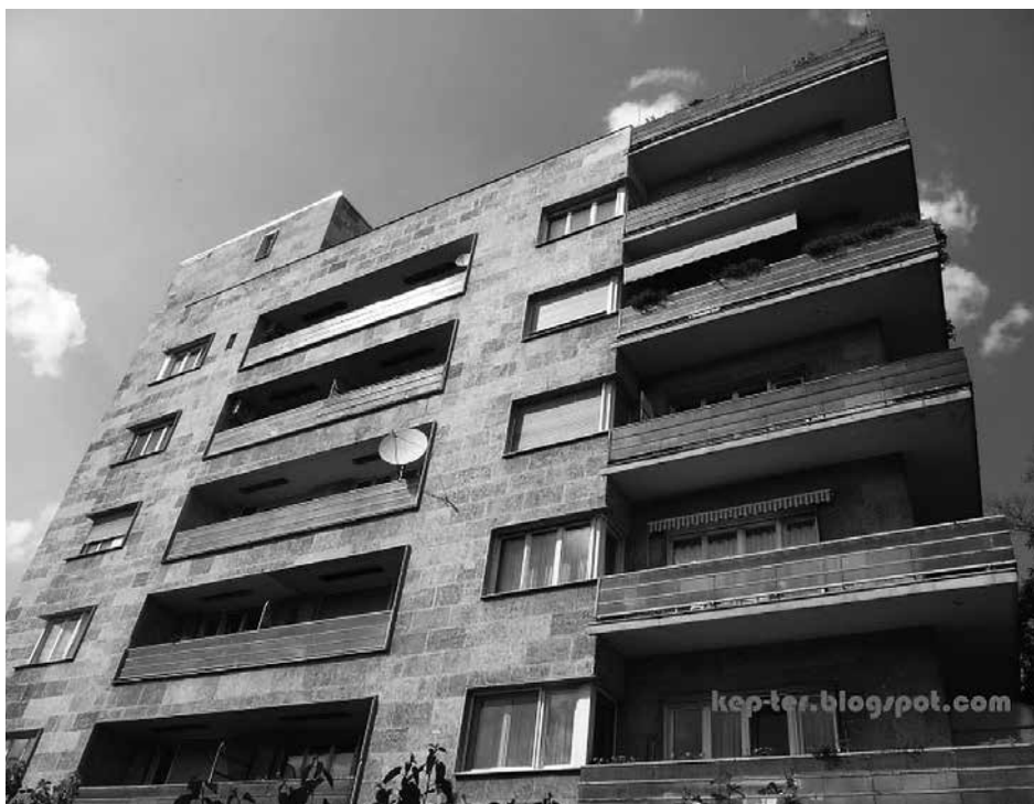
A DUNAPARK KÁVÉHÁZ ÉPÜLETE
