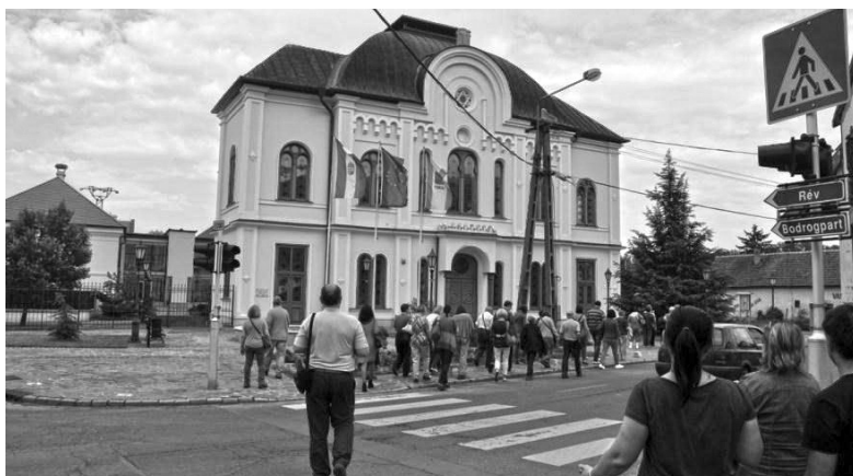
TOKAJ, A ZSINAGÓGÁBÓL ÁTALAKÍTOTT KULTURÁLIS KÖZPONT
