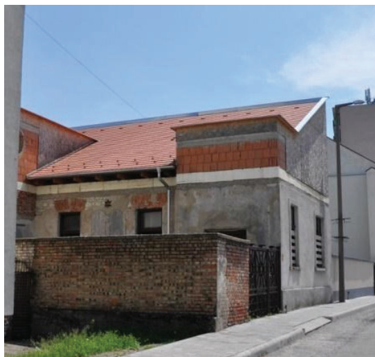
SÁTORALJAÚJHELY, AZ ORTODOX ZSINAGÓGA ÉPÜLETE
